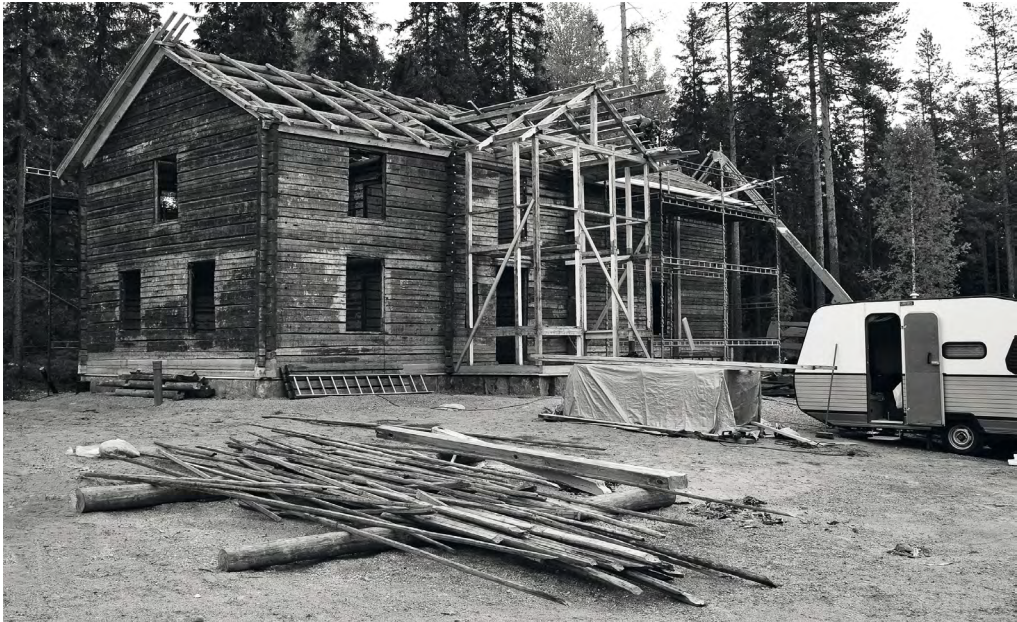
Kuva 6. Siirrettyä Haapa-ahoa rakennetaan Ähtärissä.
